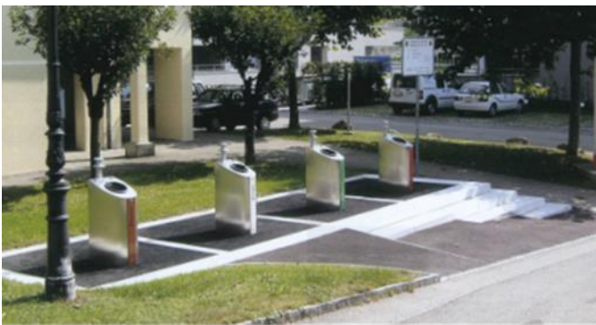
Abbildung 3: Beispiel einer Unterflursammelstelle
