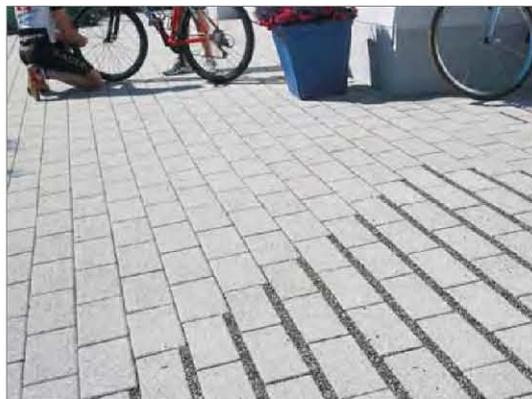
Abb. 13: Versickern mit Oberflächenabfluss, [www.braun-steine.de](http://www.braun-steine.de)
