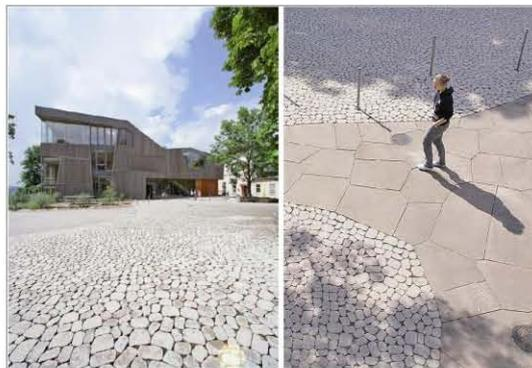
Abb. 12: 100% Versickern ohne Oberflächenabfluss, [www.braun-steine.de](http://www.braun-steine.de)
