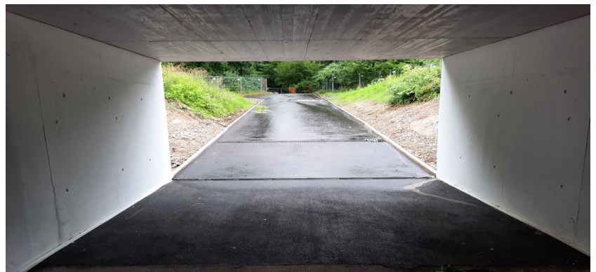
Die Fussgängerunterführung Brandholzweg wurde verlängert.
