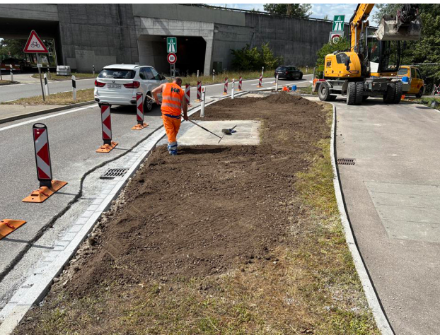
Am Anschluss Wallisellen wurde die Auffahrtsrampe Richtung St. Gallen sicherer gemacht.
