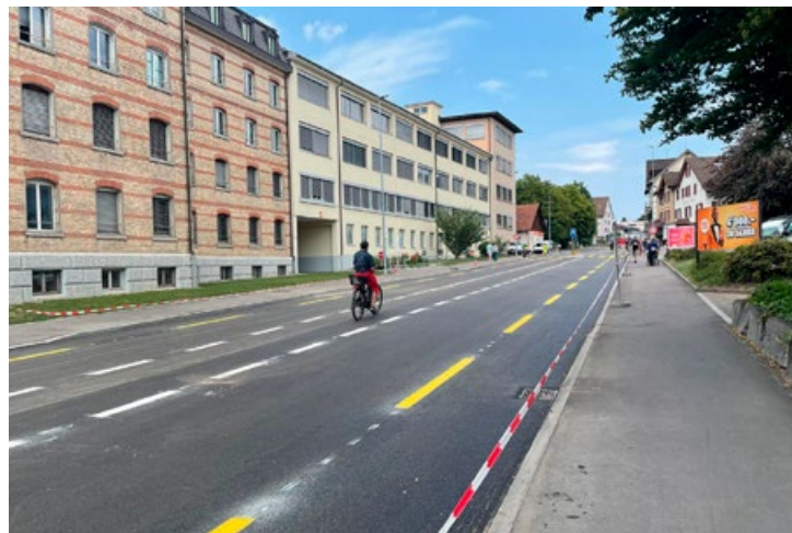
Das Zürichstrassenfest signalisierte das Ende der Bauarbeiten an der Zürichstrasse.
